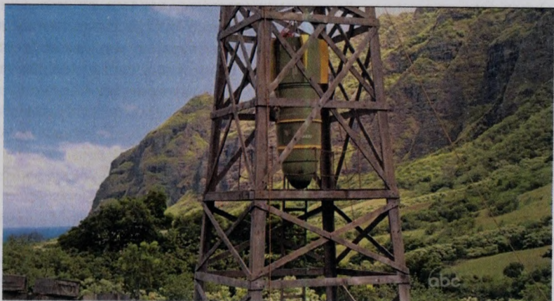
Установка «Слойки» на башне
