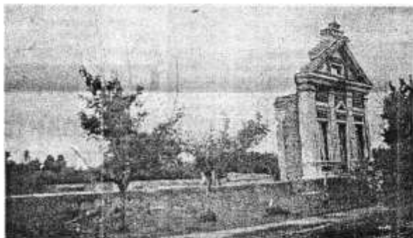
Разрушенное здание средней школы на улице Котовского в Гомеле
